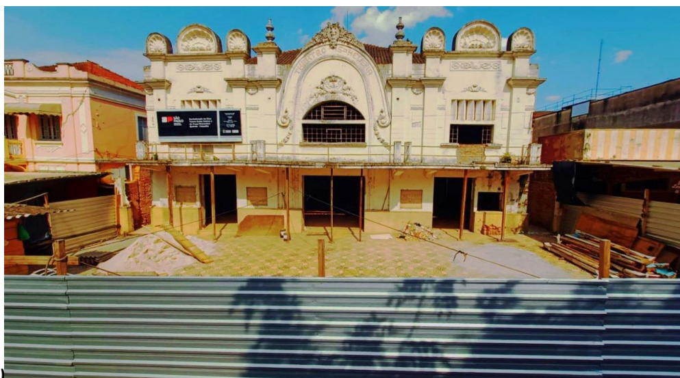
Figura 27: Cine-Teatro Santa Helena (obra em andamento,
