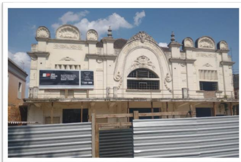
Figura 10: Revitalização do Cine Santa Helena (obra em andamento)
