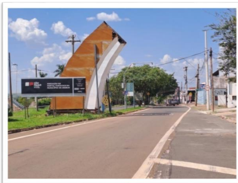
Figura 11: Implantação do Portal Turístico de Araras (obra em andamento)
